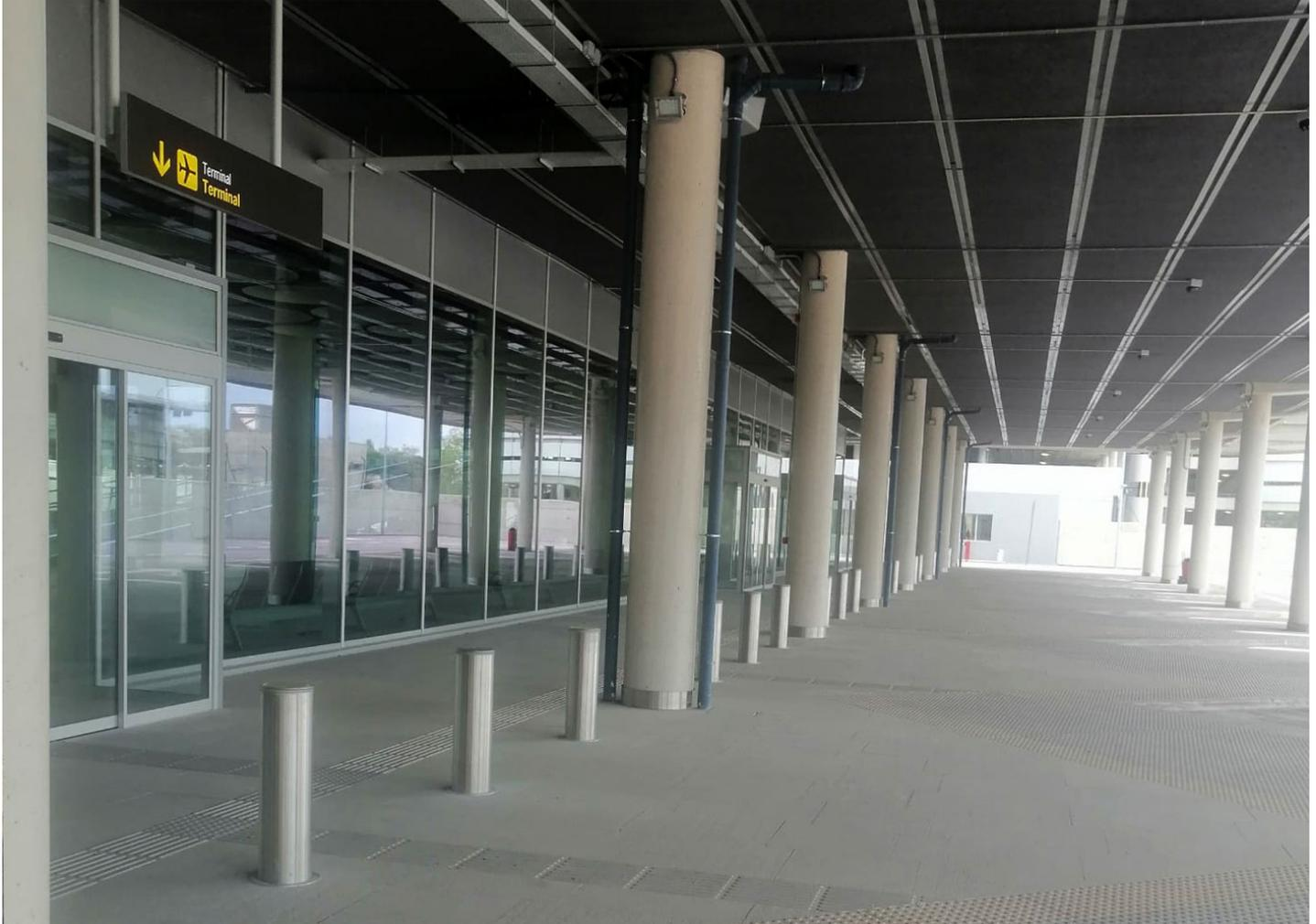
Fixe de sécurité Ø220 HS1200    Télescopique Automatique Ø220 x 600mm H6008
