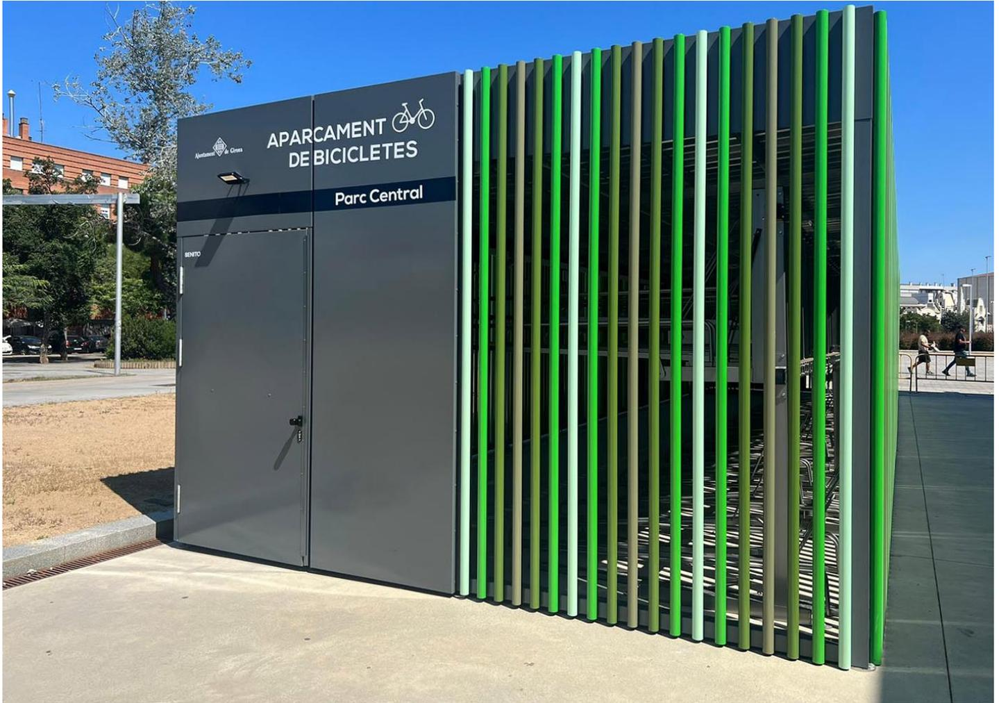
Dans le Parc Central de Gérone, à côté de la gare TGV, de la gare routière et près de la gare Renfe, un parking d'une capacité de 70 vélos a été installé. Il est constitué d'une structure métallique basée sur des profilés laminés colorés et est conçu pour être flexible afin de pouvoir être agrandi ou réduit, ou déplacé vers un autre endroit si nécessaire à l'avenir.
